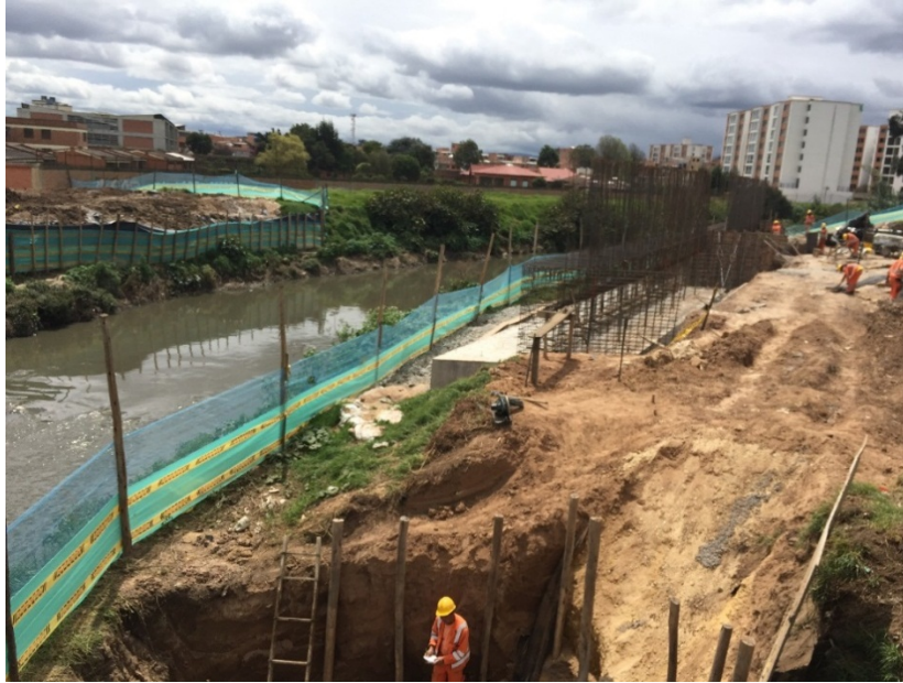
Fotografía 2. Panorámica donde se indica la zona proyecto de la construcción el Cabezal No.1, objeto de la solicitud de permiso de ocupación de cauce.
