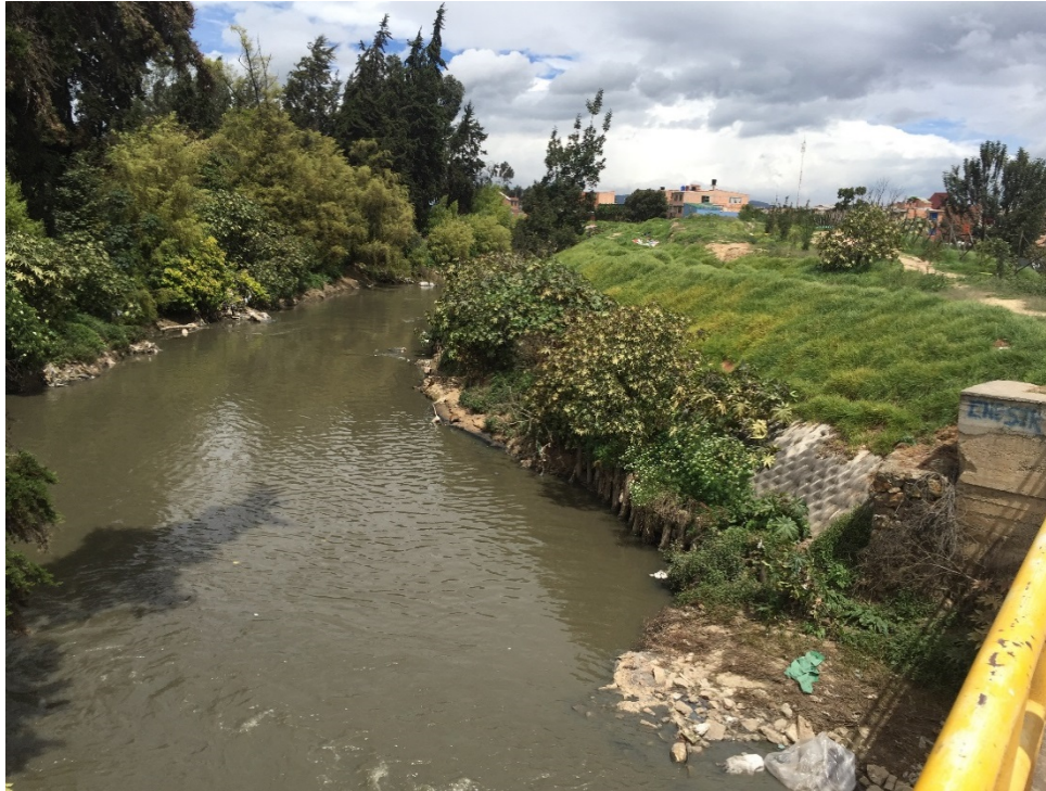
Fotografía 4. Panorámica, Costado nororiente proyecto Descole No. 2 Tubería de 36” ZMPA del Río Tunjuelo.
